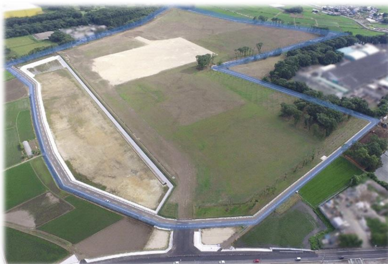
つくば明野北部（猫島地区）工業団地
