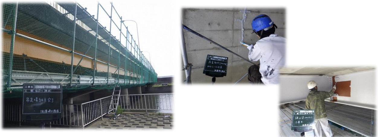
橋梁点検の様子
