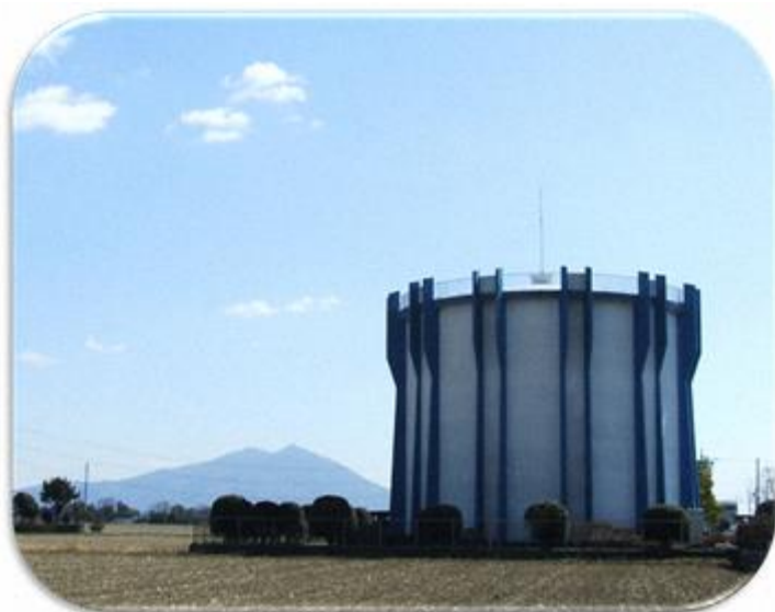
成田浄水場配水池
